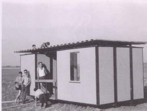
14. kép. Magyarhomorog-Kónya-domb. Az MNM szétszedve szállítható faháza, amelyet a teraszon álló Juhász Pál asztalos vezetésével állítottunk össze. Balra Kovács László és Pónyai Sándor (1966)
