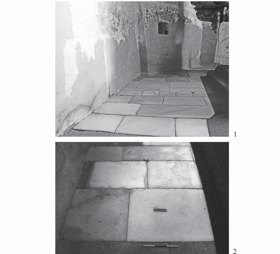
Abb. 2. 1. Innenraum der bestehenden gotischen Kirche (rechte Seite des Chorraums) mit den Resten der vorromanischen Apsis und den weißen Marmorplatten am Sockel, 2. Innenraum der bestehenden gotischen Kirche (linke Seite des Chorraums). Marmorplatten mit der Vertiefung für die Chorschranke
